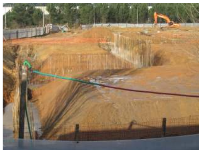
Figura 176 – Fotografia das actividades de criação de plataforma para a instalação do pavilhão industrial (2009).
