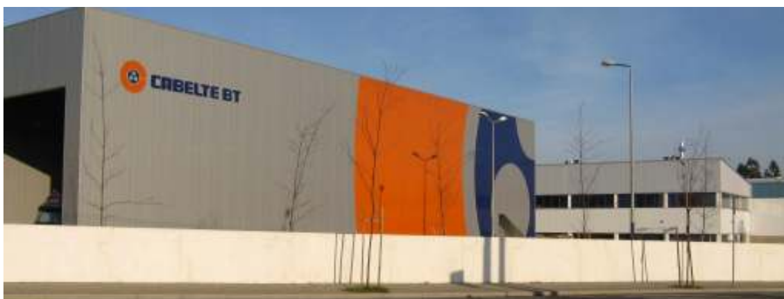
Figura 92 – Perspectiva geral (ao fundo na foto superior) e particular (foto inferior) da unidade da Cabelte.
