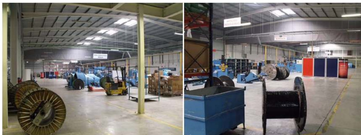
Figura 173 – Vista geral da nave – vista poente-nascente (esq.) e vista da área de intervenção (dta.).
