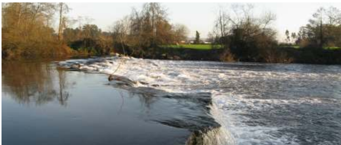
Figura 67 – Margem esquerda do rio Ave e açude no leito do rio.
