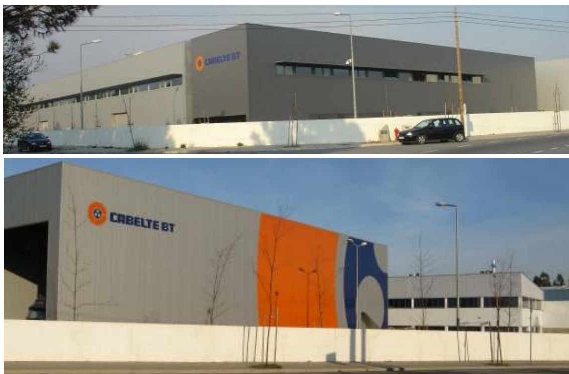
Figura 14 – Vista da unidade em estudo.
