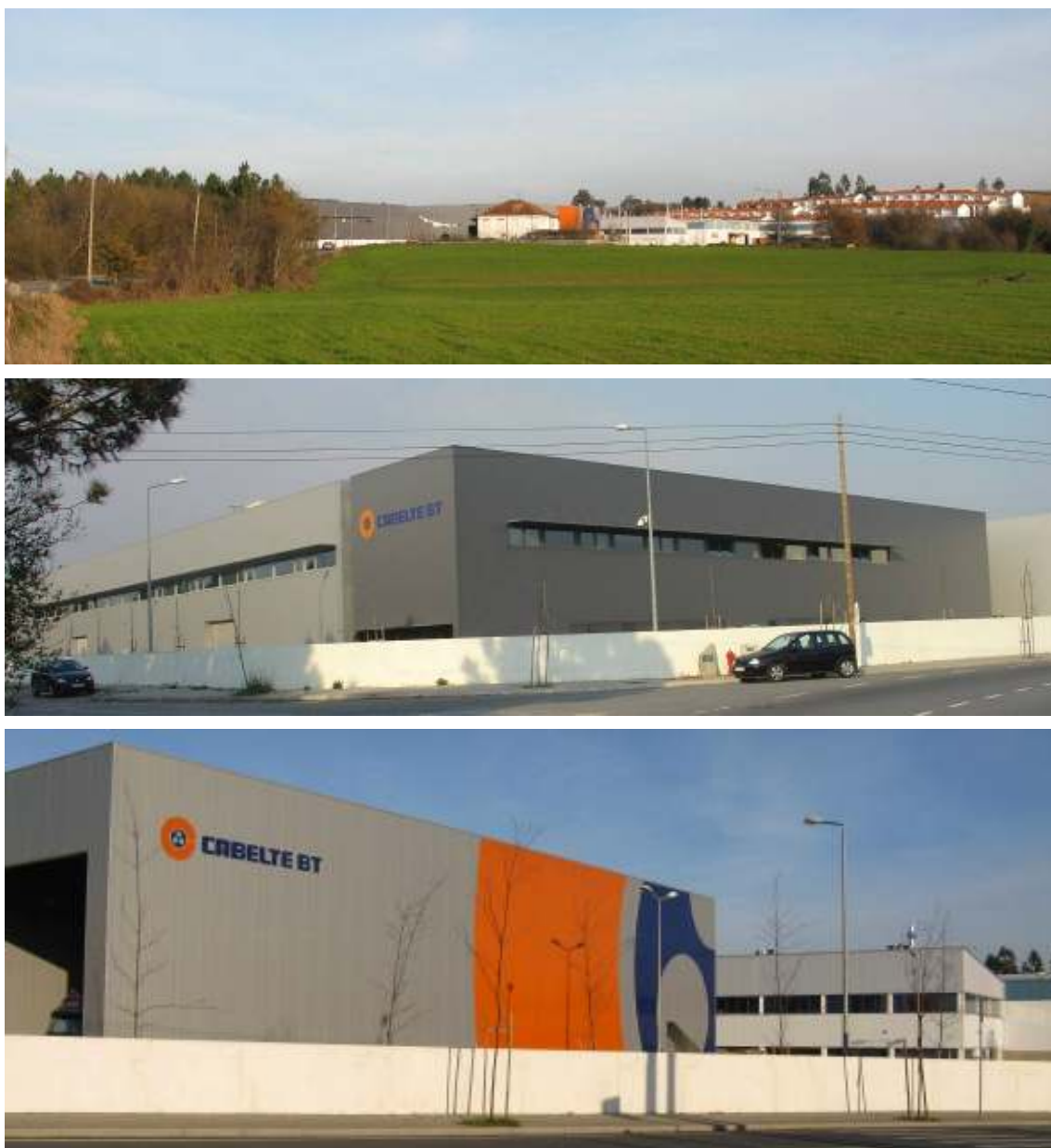
Figura 51 – Perspectiva geral (ao fundo na primeira foto) e particular da unidade da Cabelte.
